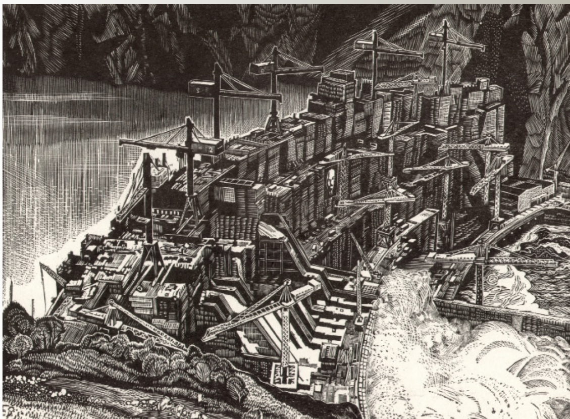
Строительство Саяно-Шушенская ГЭС. Литография. 24x34 см.
